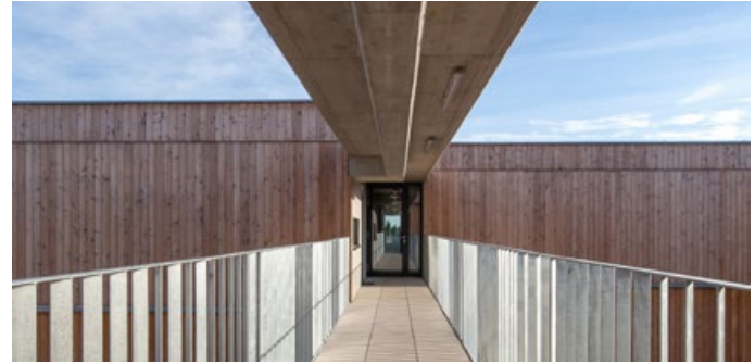
HOLZWOHNBAU SEESTADT ASPERN, WIEN, A / 2015
