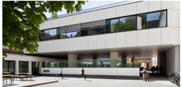
SCHULERWEITERUNG ADOLF-PICHLER-PLATZ, INNSBRUCK, A / 2015
